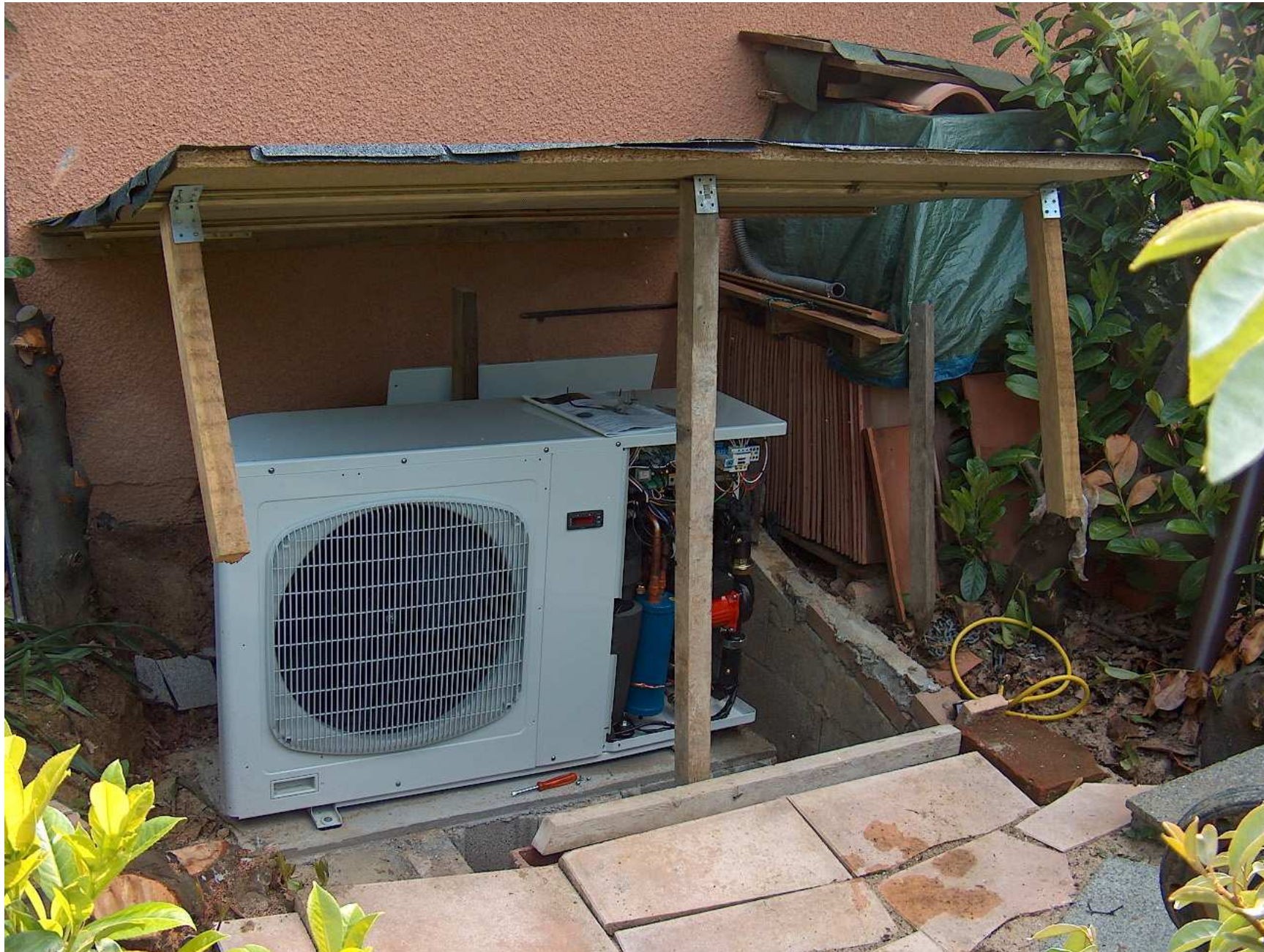
Vue externe abri ouvert
